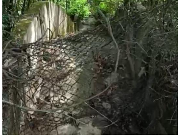
图 3.1-2 垃圾填埋场渗滤液处理站东侧冲沟
