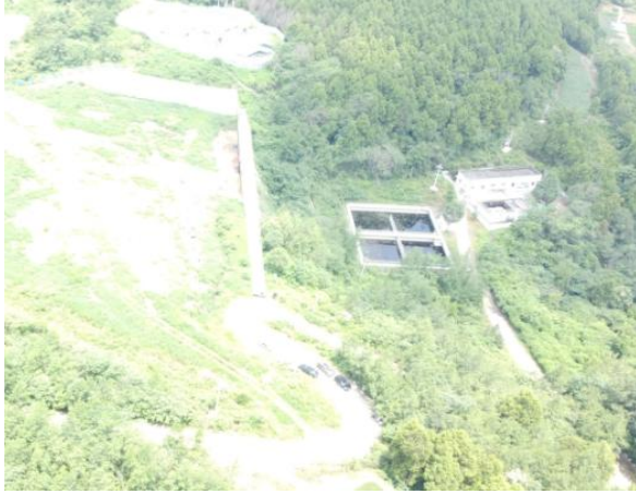
图 3.1-1 垃圾填埋场渗滤液处理站
