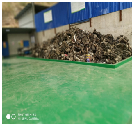
拆解车间防渗
