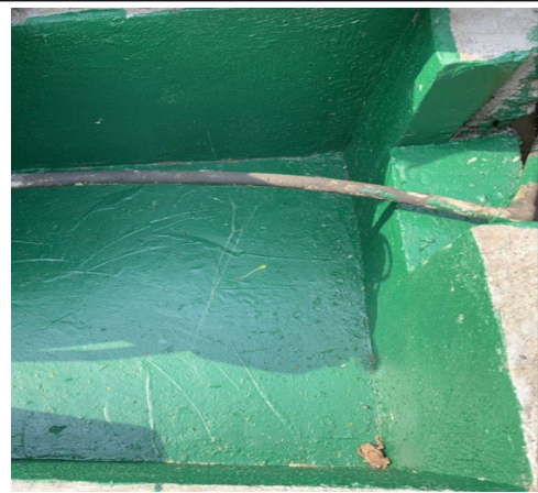
污水处理设施防渗
