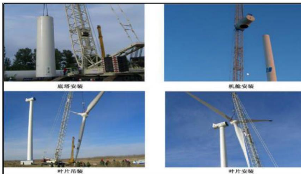
风电机组叶片安装参照图
