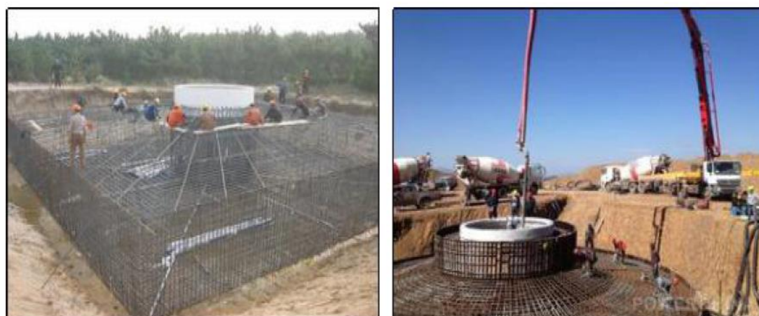
风电机组基础施工参照图
