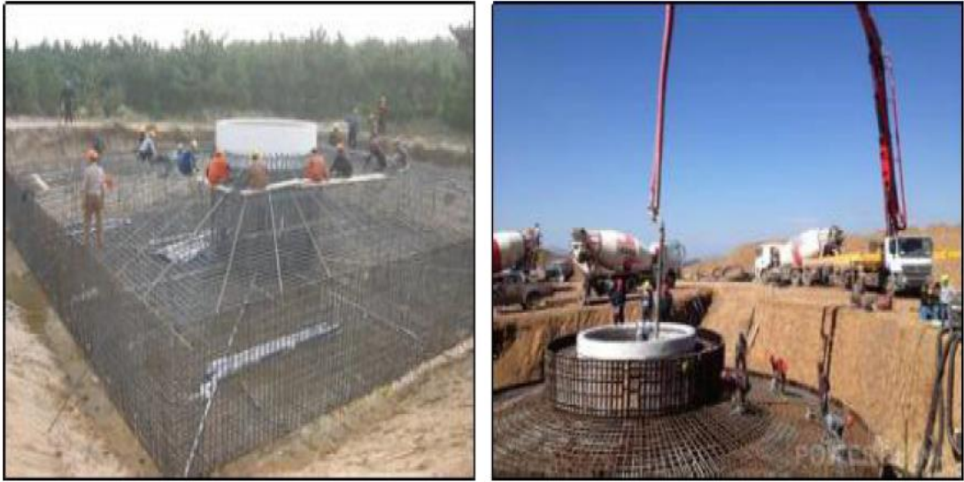
图 2-6 风电机组基础施工
