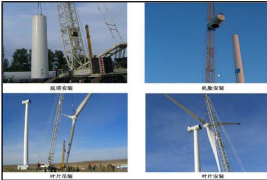
图 2-8 风电机组叶片安装
