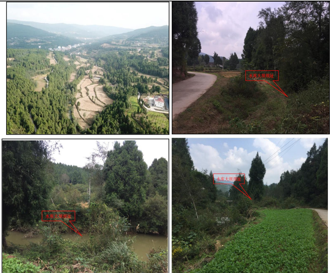
图 4-14 水库枢纽工程区现状照片
