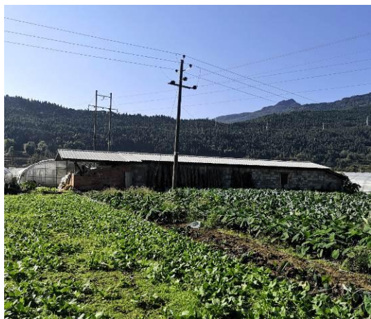
占地范围内看守大棚用房屋
