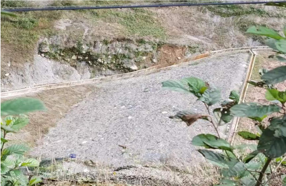
图 3-2 850 尾矿库初期坝现状
