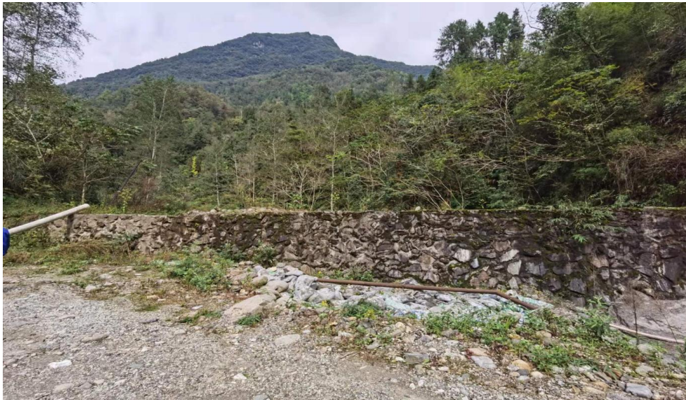
图 3-5 850 尾矿库挡水坝现状
