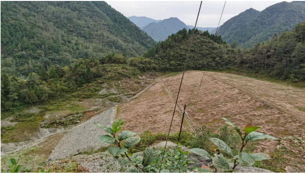
图 3-3 850 尾矿库堆积坝现状
