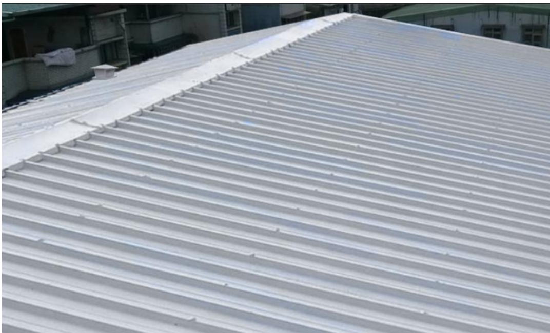
图 9-3 医院楼顶通风口
