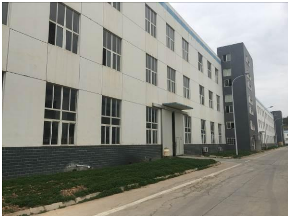
项目东侧 10#厂房
