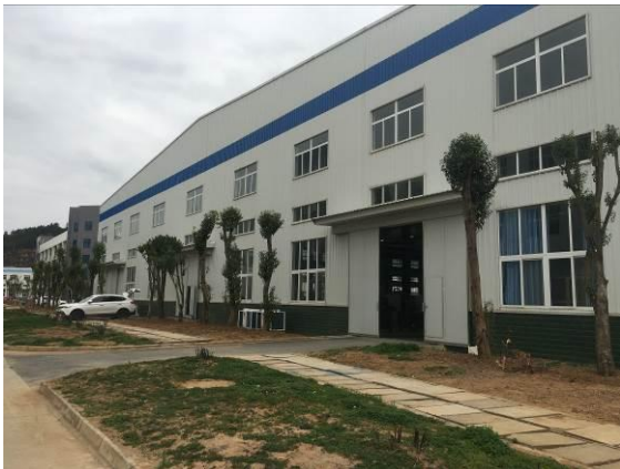
项目北侧同期新建的机电产业项目厂房
