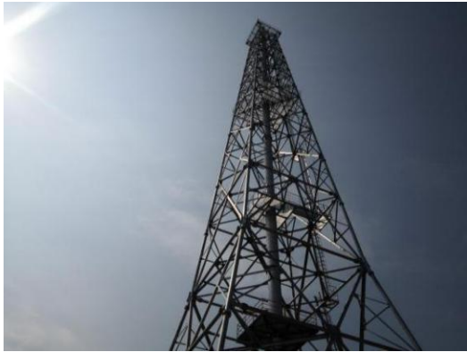
尾气排气筒 (H=100m)
