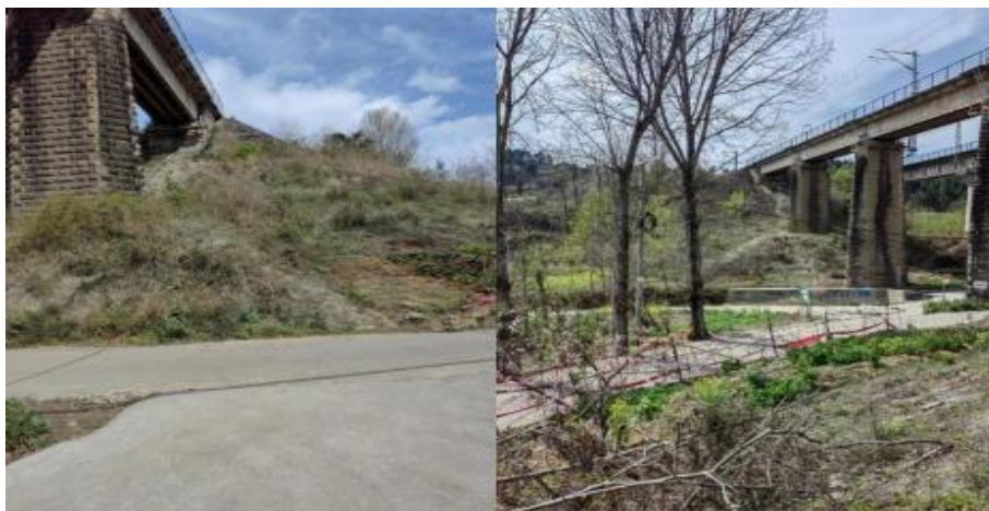
图 2-1 李家沟三线大桥桥位地形
