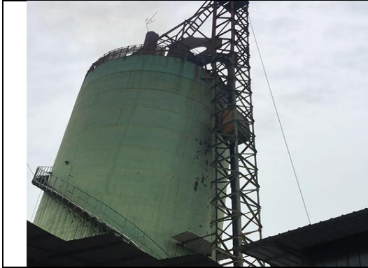
炉窑现场照片（一）
