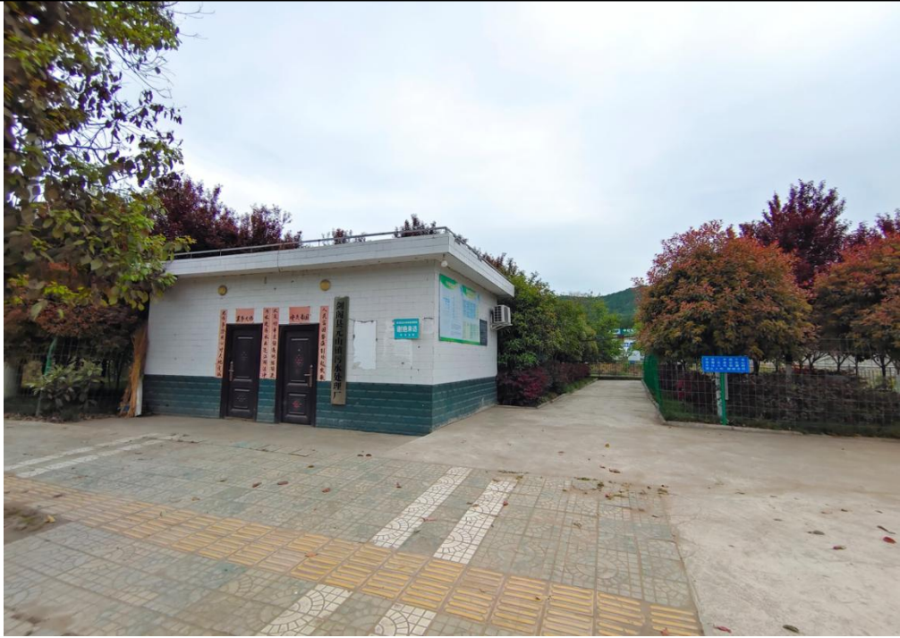
图 2-6 现有污水处理厂现状
