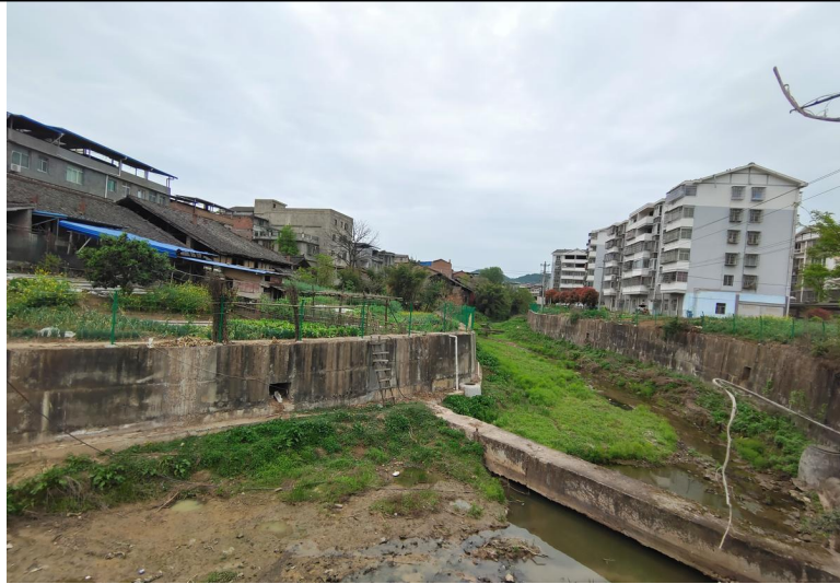
图 2-5 本项目收水管线拟建地（柳河沿线）现状
