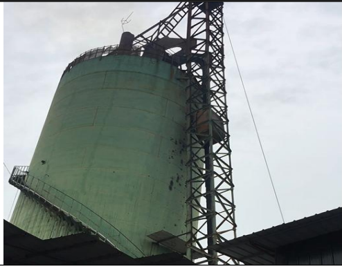
炉窑现场照片（一）
