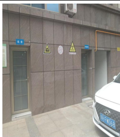
医疗废物暂存间
