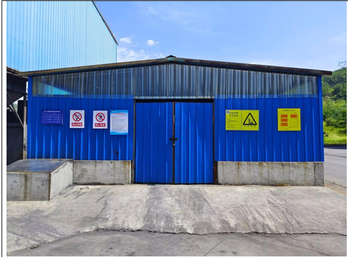
厂区内已建的危险废物贮存库
