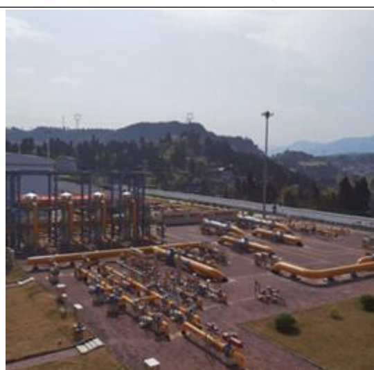
图 2-2 广元输气站现场航拍图
