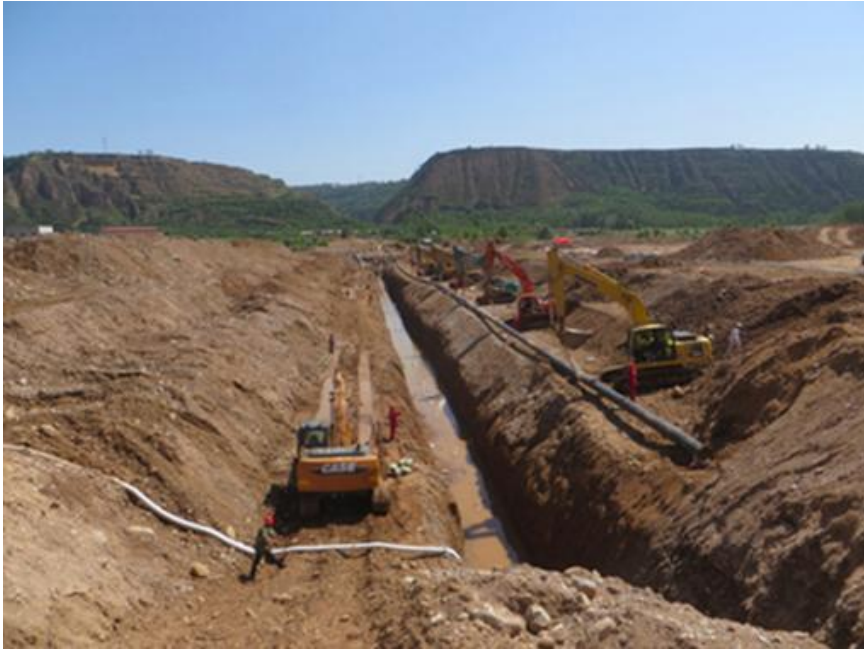
图 3-3 天然气管沟工程开挖实景图片
