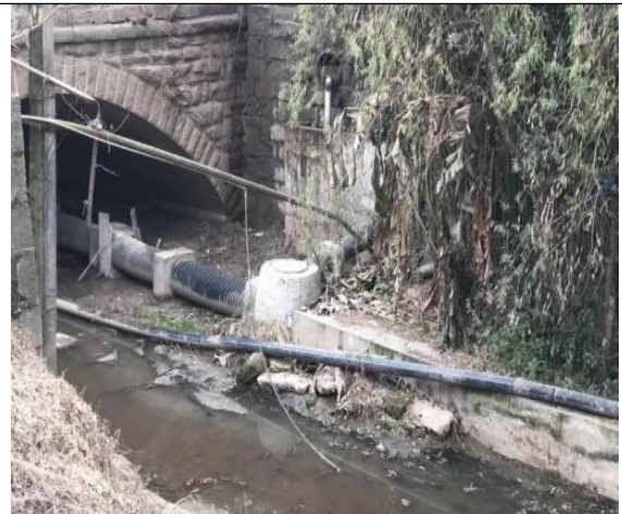
沿河污水管道破损
