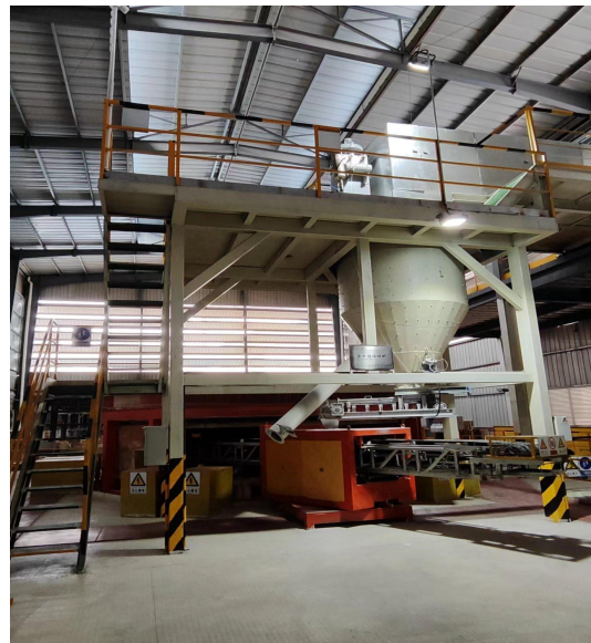
四川环球集团（五粮液）54 吨钠钙玻璃电熔炉
