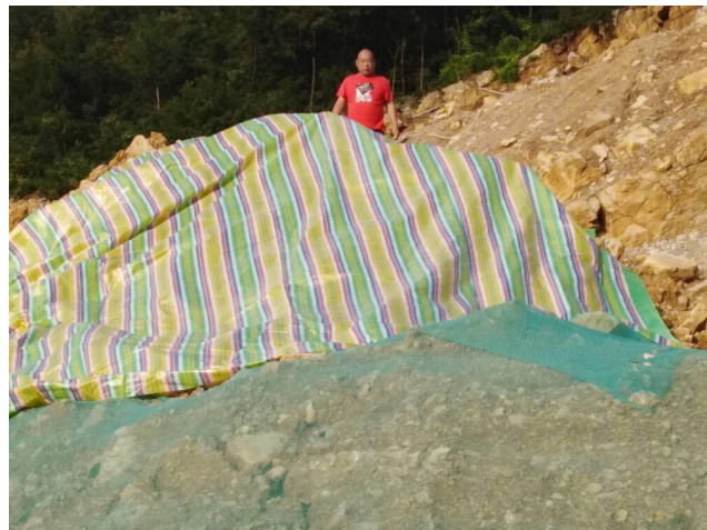
现有弃渣回填区挡墙及堆渣后覆盖
