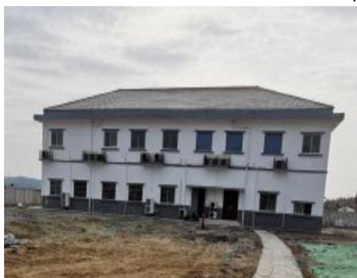
存车场办公楼
