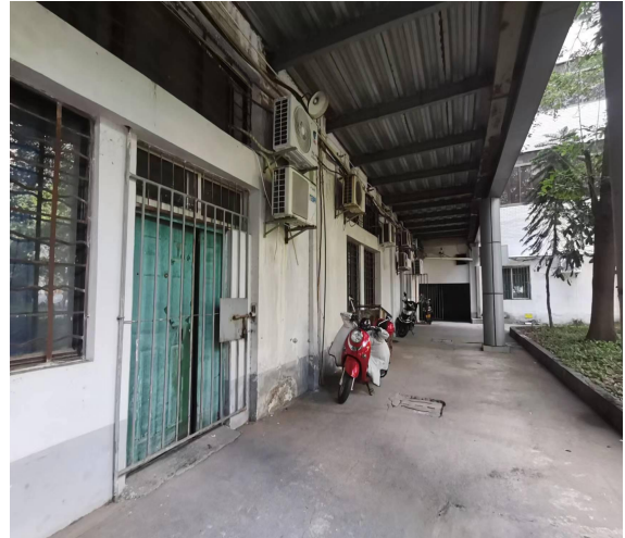
过道、庭院 (DSA机房东侧)
