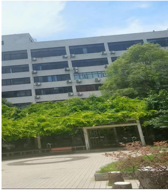
门诊楼（DSA机房位于负一层）
