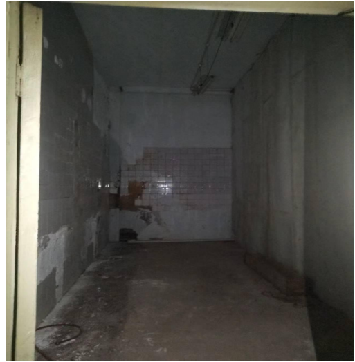
杂物间 (DSA机房北侧)
