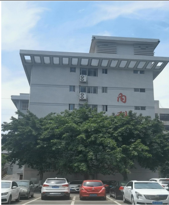
内科楼（门诊楼南侧）
