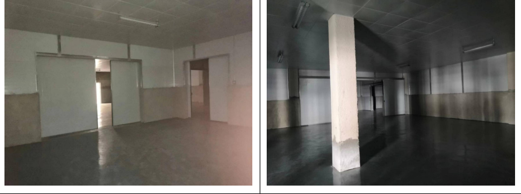
图 2-12 项目现场照片
