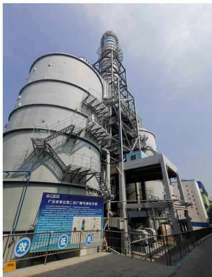
电解烟气脱硫净化系统及其排气筒
