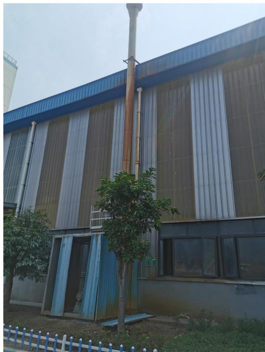
炭渣处理电解质烘干及成品储运废气排气筒
