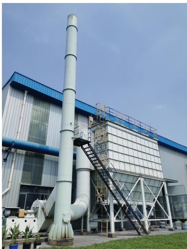
中频炉熔炼和浇注粉尘除尘器及其排气筒
