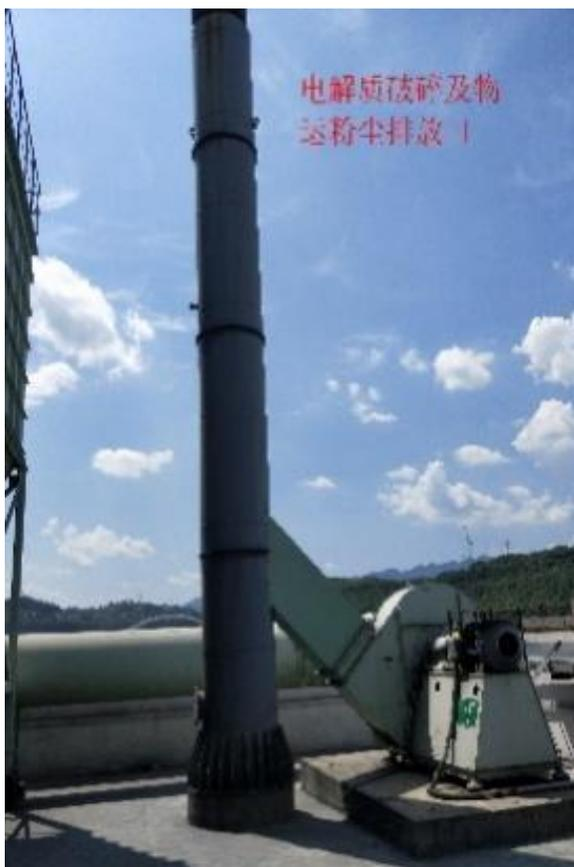
电解质反击破碎、筛分及物料输送、电解质料仓粉尘除尘器及其排气筒
