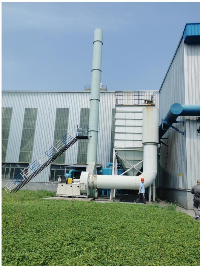
磷铁环压脱及滚筒清理粉尘除尘器及其排气筒
