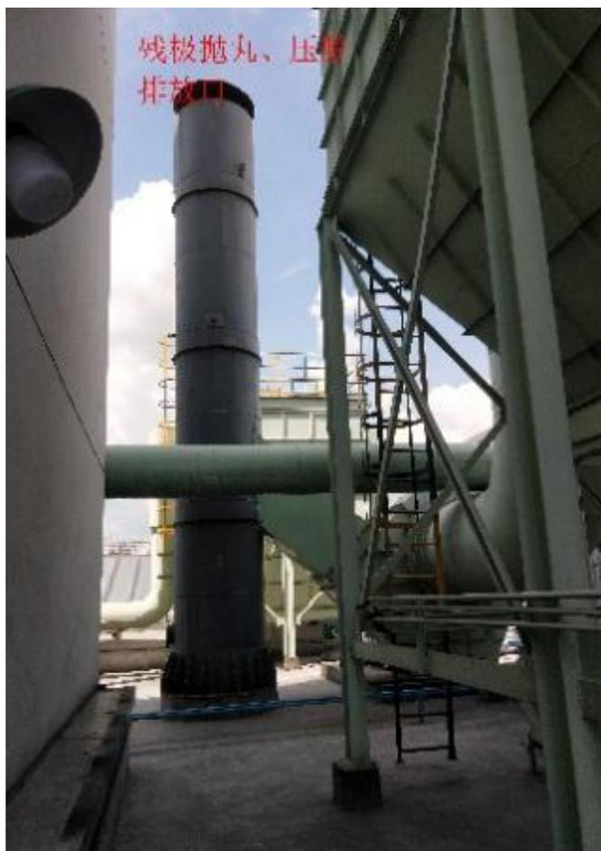
残极压脱粉尘除尘器及其排气筒
