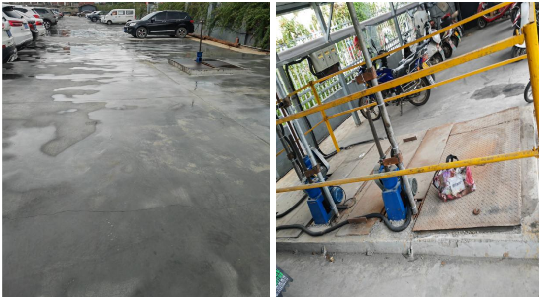
初期雨水收集池 (地埋式)
