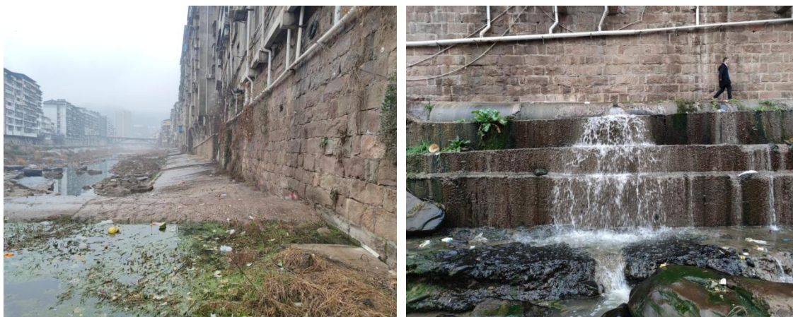
图 2-3 河道两侧污水管网现状
