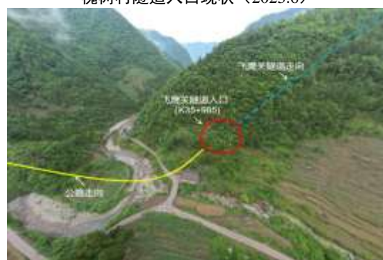
飞鹰关隧道入口现状（2023.6）
