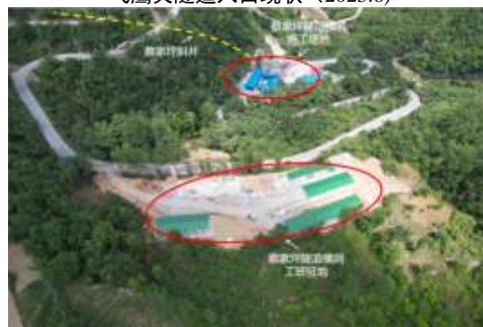
蔡家坪横洞施工场地现状（2023.6）
