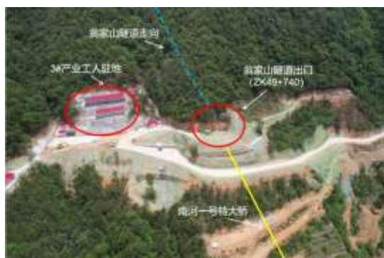
翁家山隧道出口现状（2023.6）
