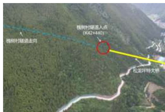
槐树村隧道入口现状（2023.6）
