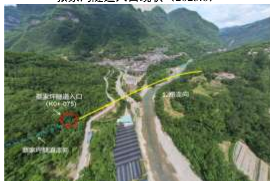
蔡家坪隧道入口现状（2023.6）
