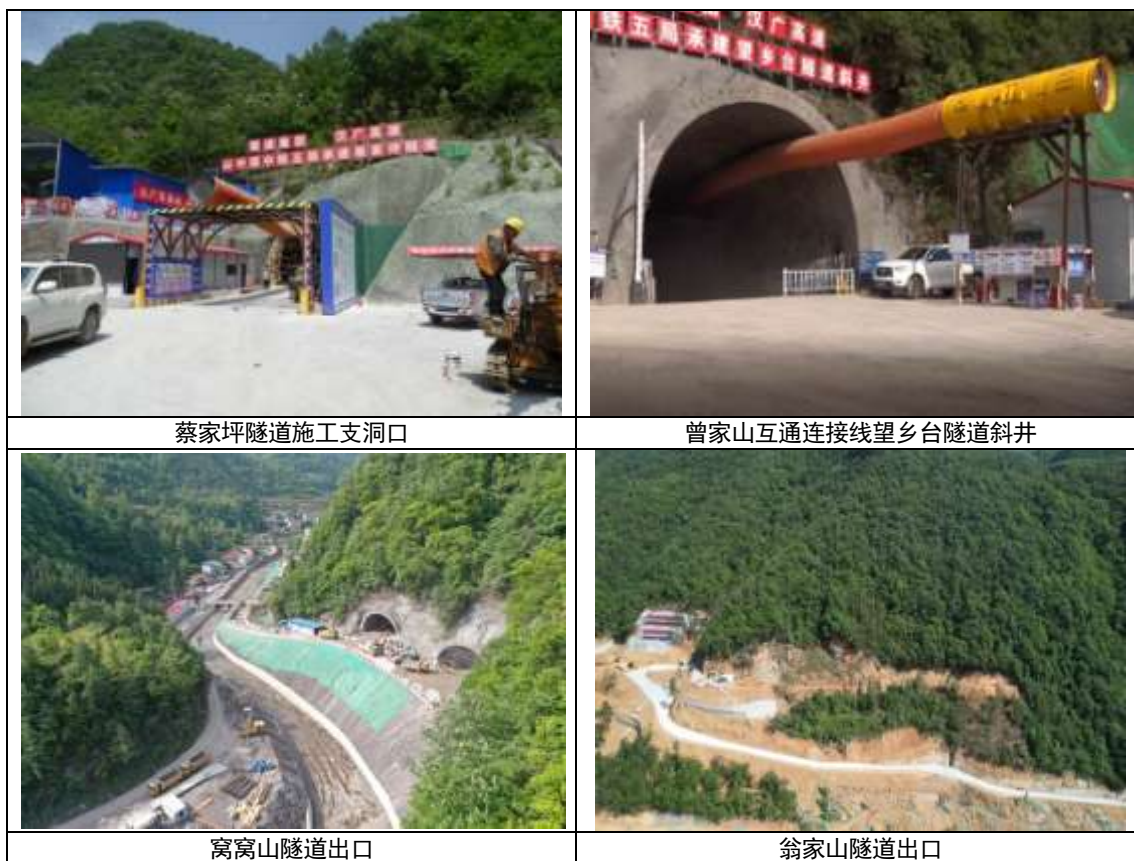
图 2.8-1 主体工程施工现场照片
