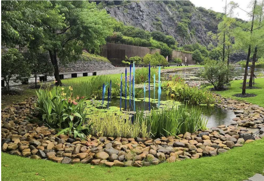
图2.1-3 干砌块石驳岸示意图
