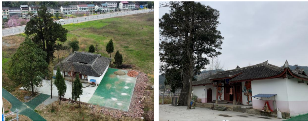
图4.1-1 项目北侧古柏和三觉寺
