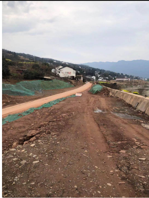
起点：建范家立交匝道口
