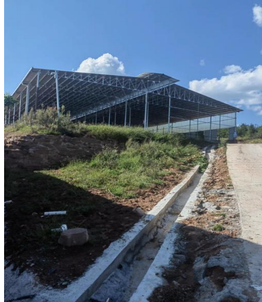
项目厂区在建雨水沟照片
