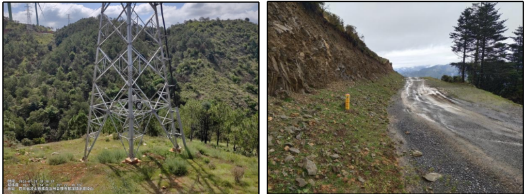
图 2-16 其他同类项目架空线路铁塔及地理线路区恢复后的现场照片
