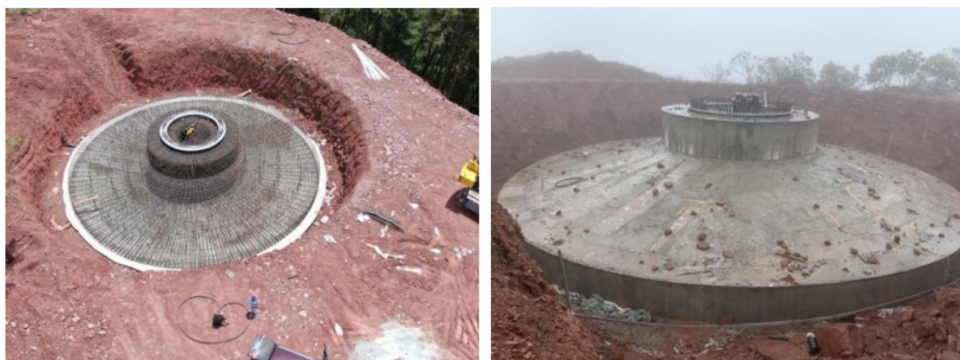
图 2-9 风电机组基础施工案例图
