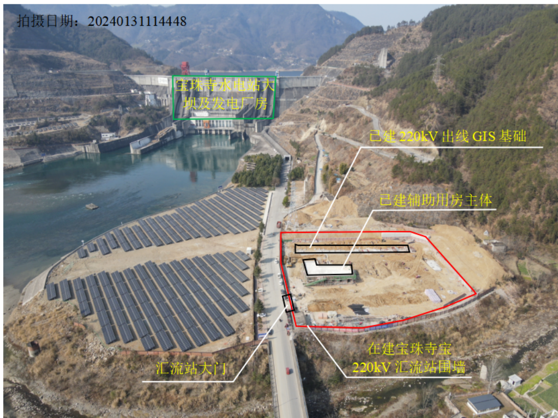
图 2-4 宝珠寺 220kV 汇流站建设情况
