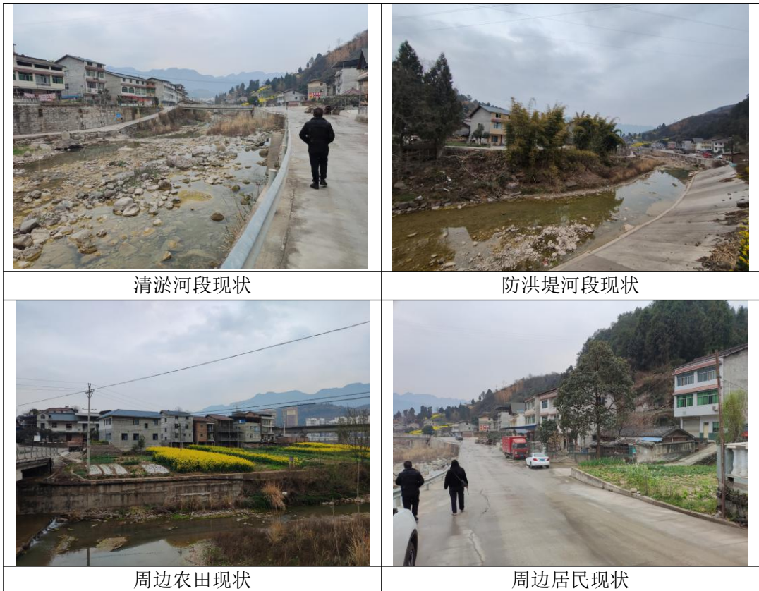
图 3-2 本项目现状照片
