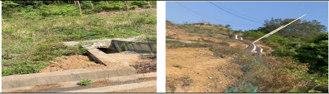
图 2-5 已有排水沟渠现状图
