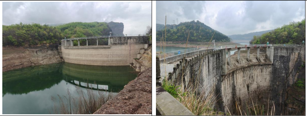
图 2-1 大坝和溢流坝现状
