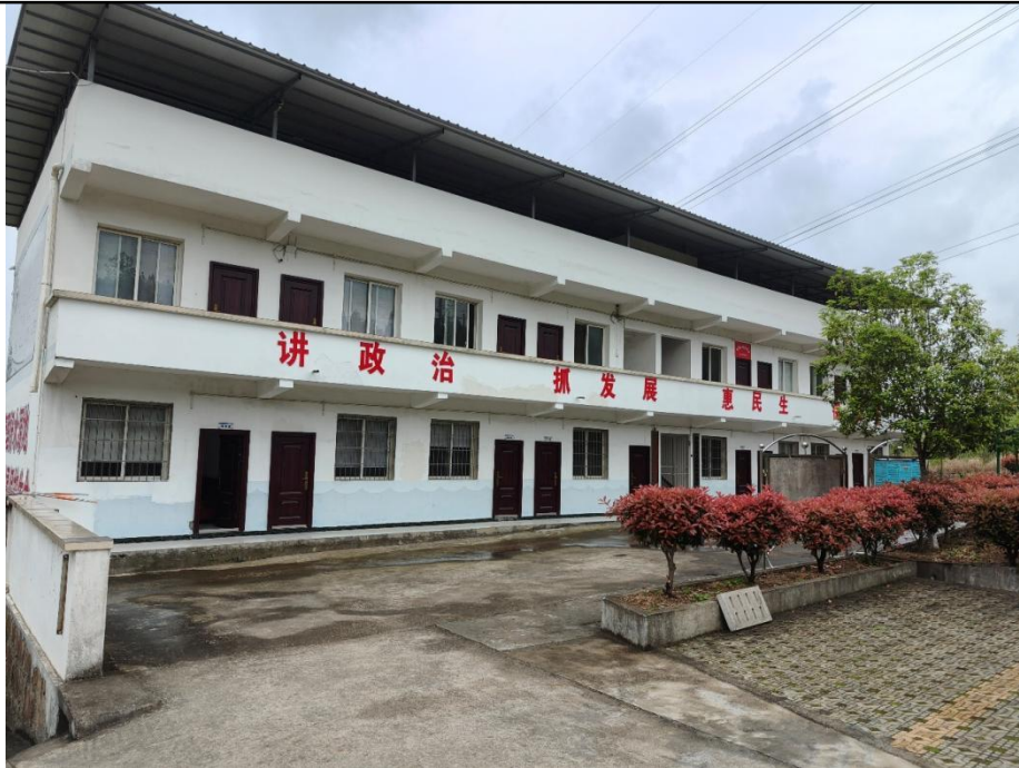
图 2-4 管理用房现状
