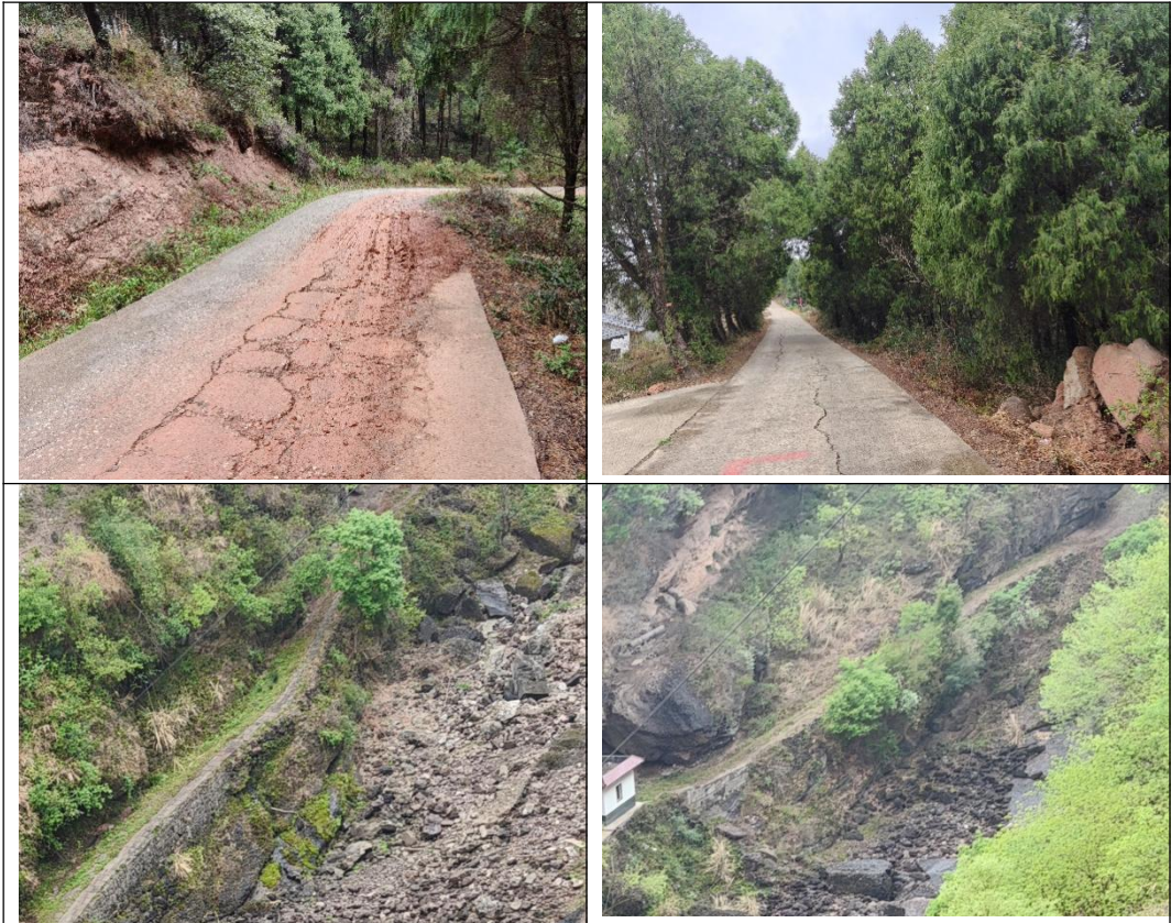
图 2-3 防汛抢险及检修道路现状
