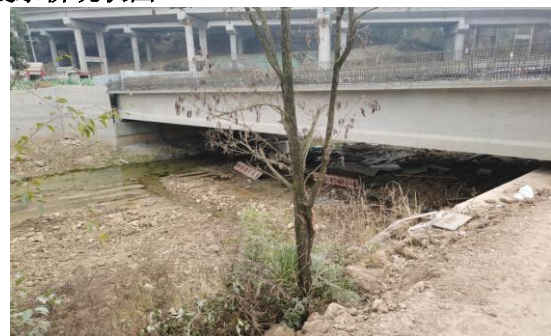
图 3-7 在建桥梁现状图
