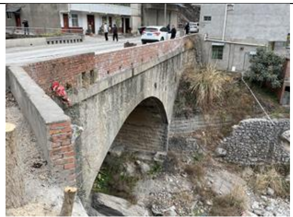
长江沟已建桥梁
