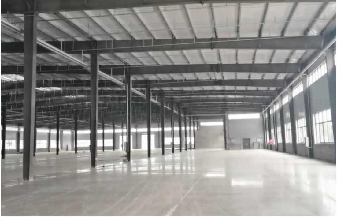
图 2-10 已建空厂房照片
