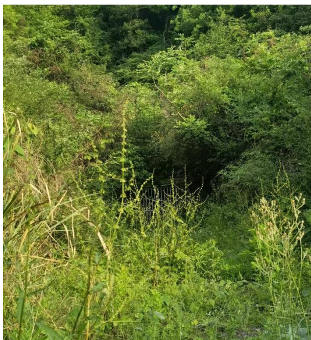
图 2.5-5 探矿坑道封堵现状
