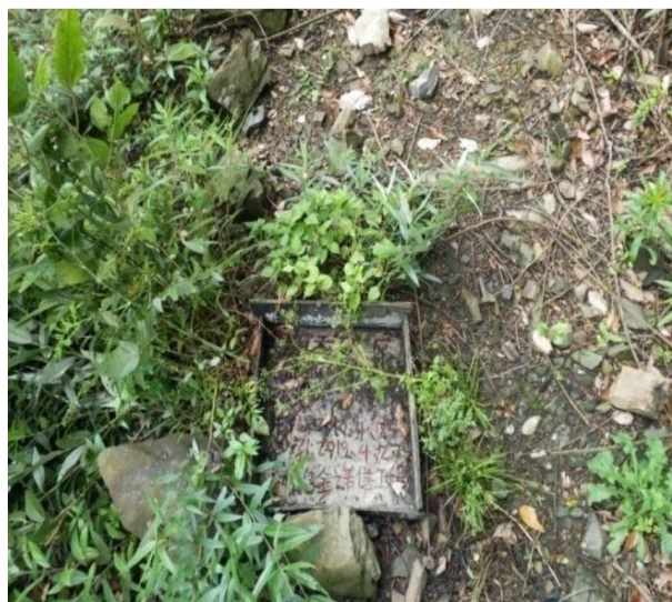
图 2.5-19 探孔封堵现状
