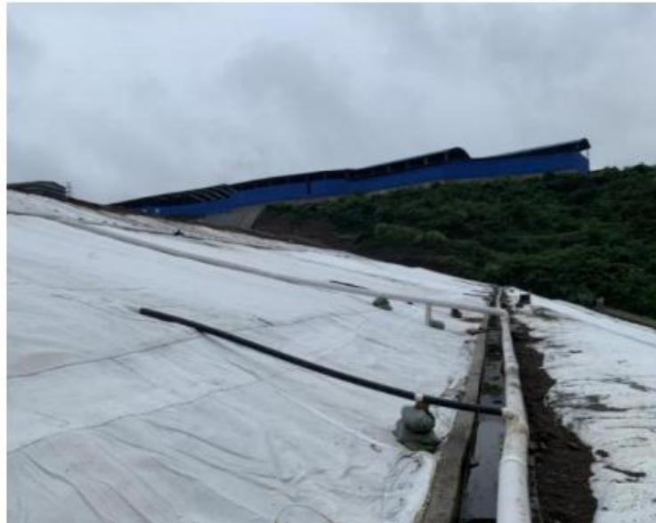
填埋场前端坡面排渗孔照片
