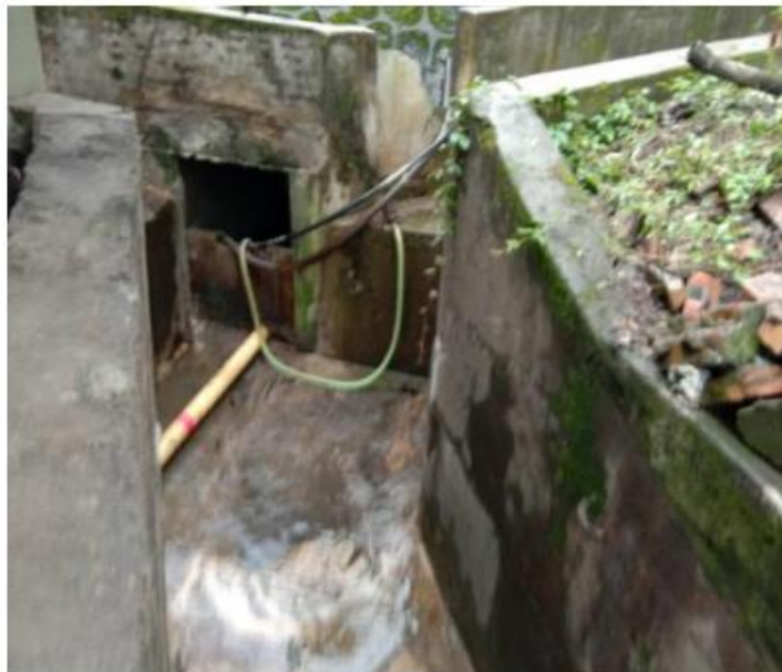
填埋场底部排洪沟照片
