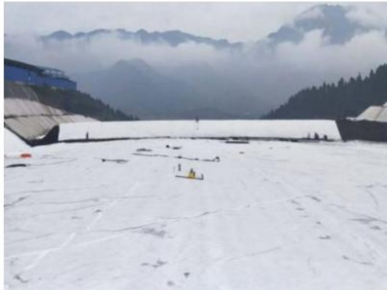
填埋场分区子坝照片
