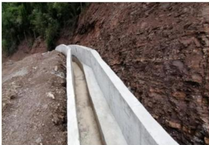
填埋场 600m 环形排洪沟照片
