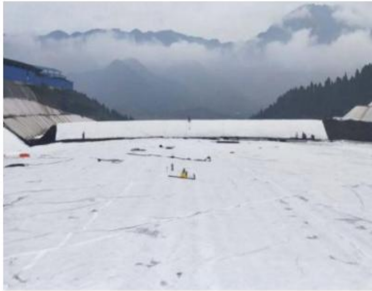
填埋场分区子坝照片
