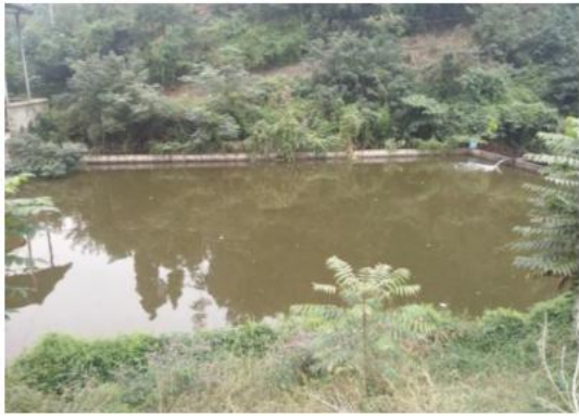
拦渣坝内侧渗滤液收集池照片
