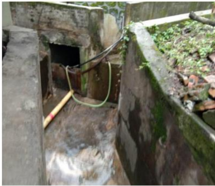
填埋场底部排洪沟照片
