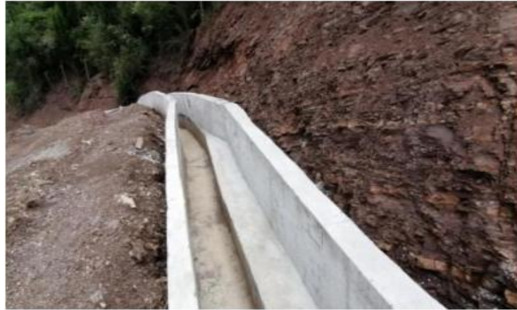
填埋场 600m 环形排洪沟照片
