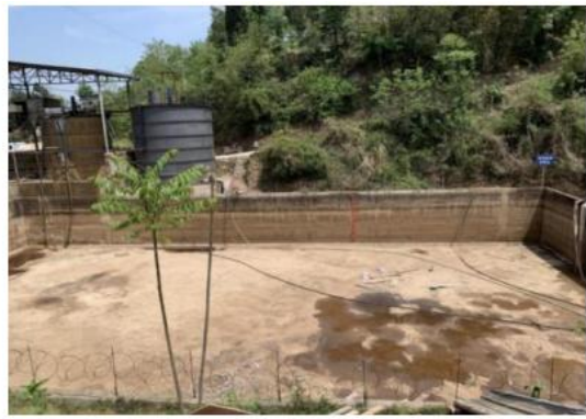
拦渣坝内侧渗滤液调节罐照片
