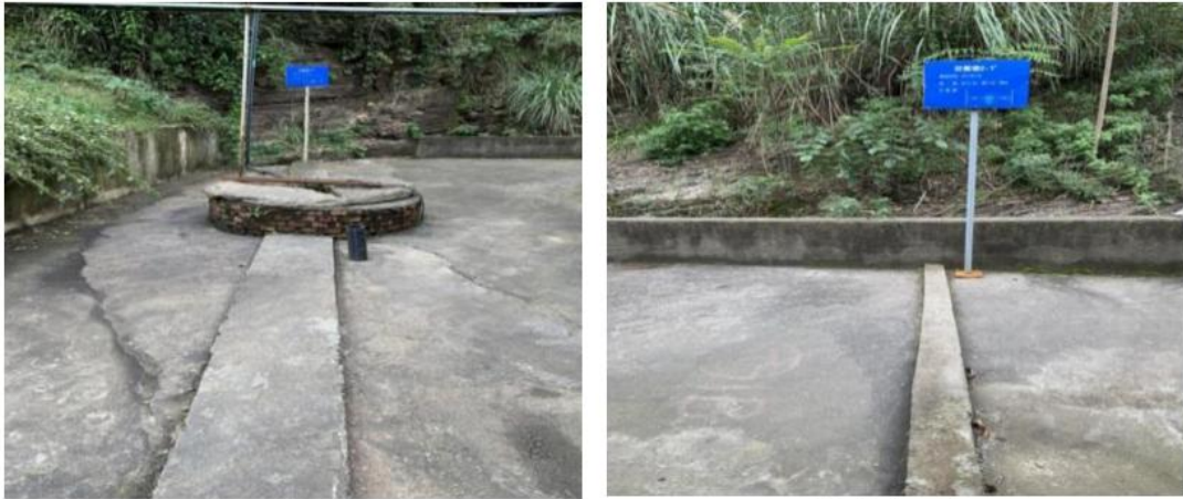
填埋场坝前二道截渗墙照片
