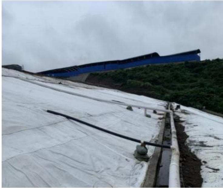
填埋场前端坡面排渗孔照片
