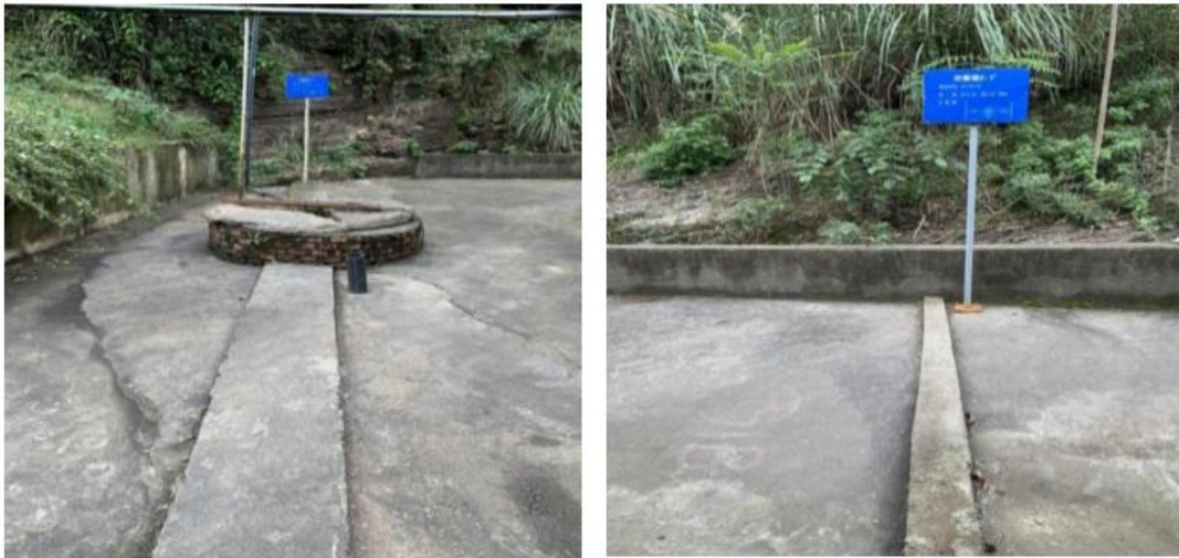
填埋场坝前二道截渗墙照片
