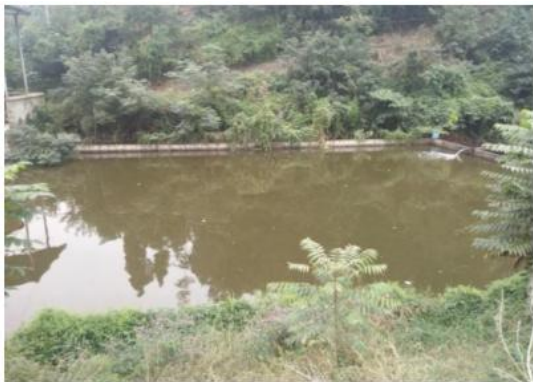
拦渣坝内侧渗滤液收集池照片
