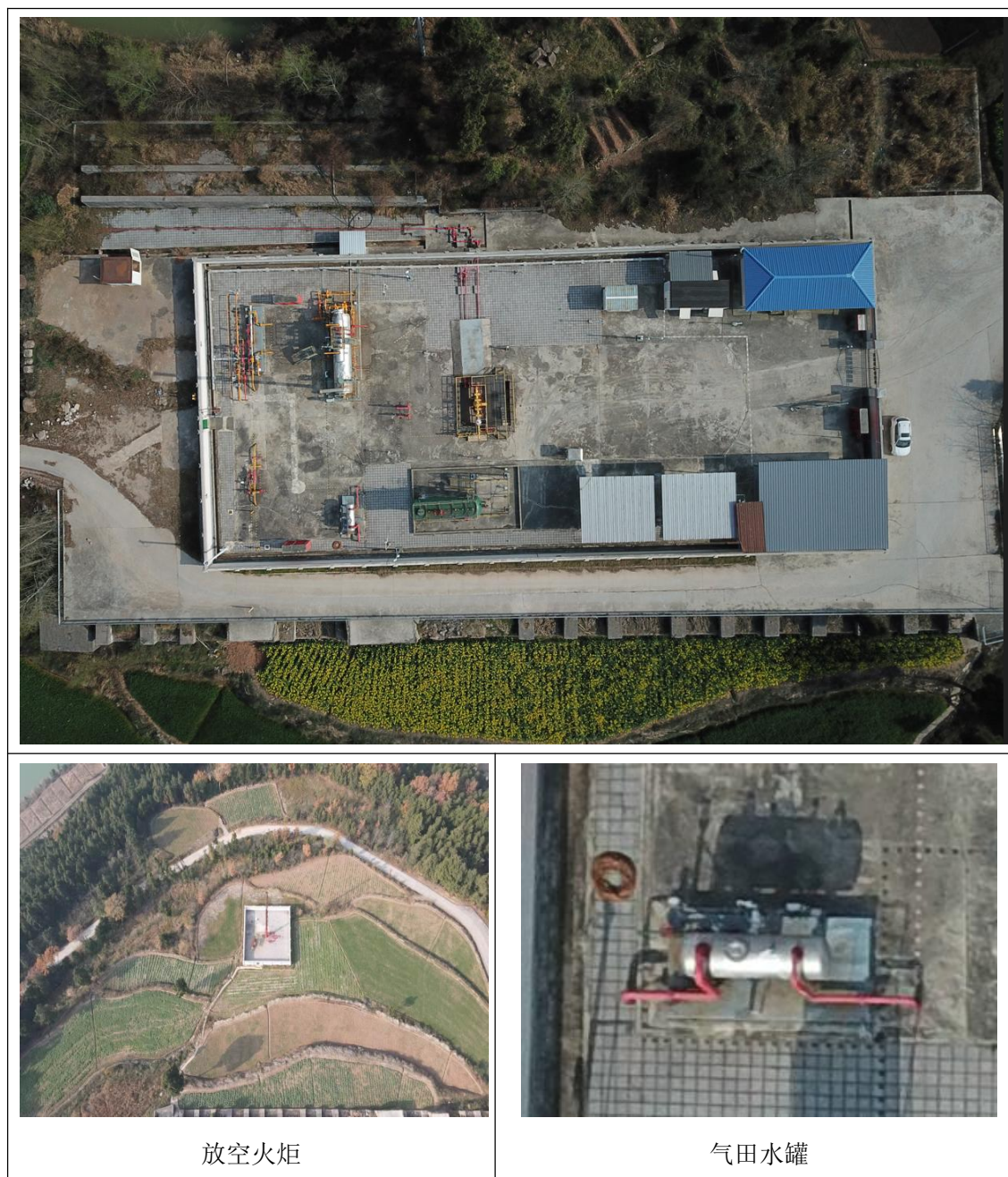
图 3.1-3 龙岗 062-C1 井站现状及环保设施照片
