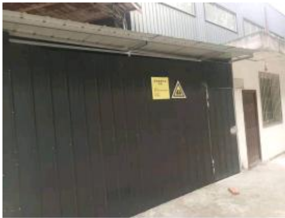
↑ 危废暂存间单独房间（样图）
