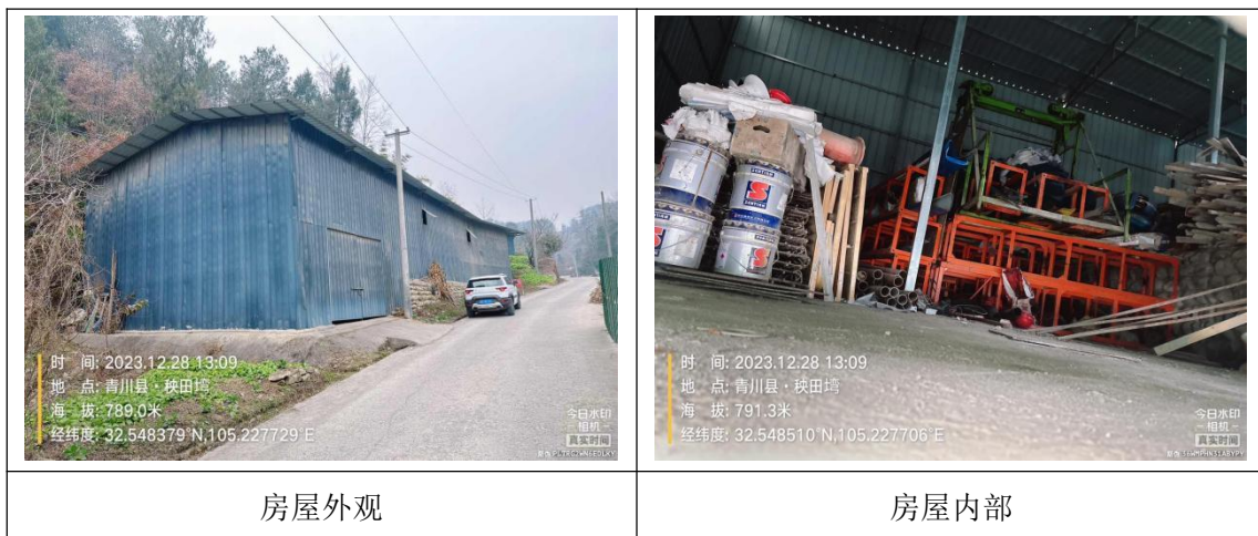
图1-5 未拆除房屋现状照片
