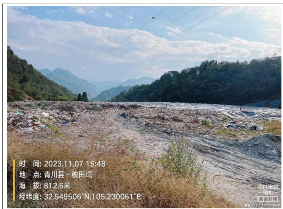
图1-6 垃圾填埋场现状照片
