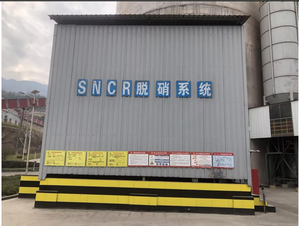
SNCR 脱硝系统
