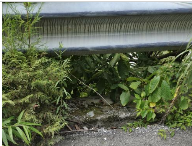
老路挡墙现状
