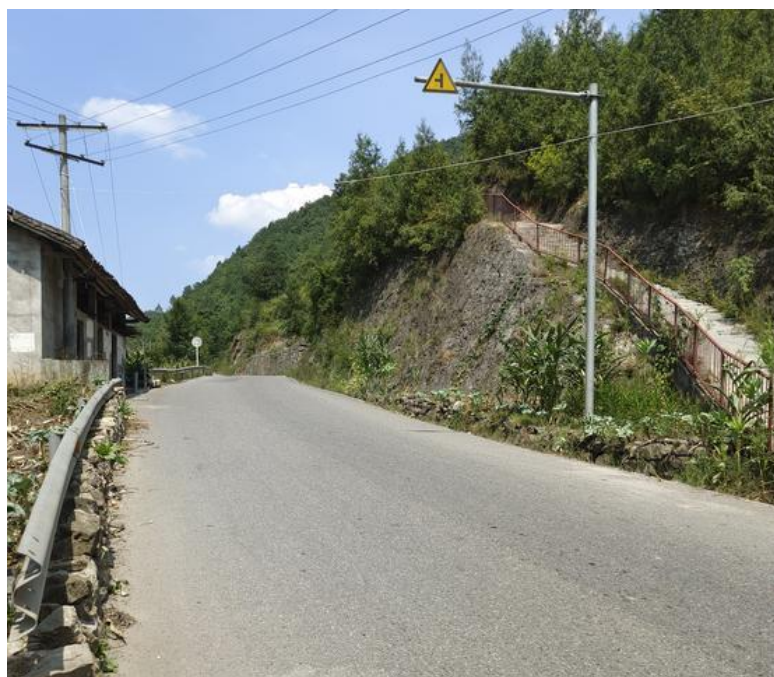
老路路基现状
