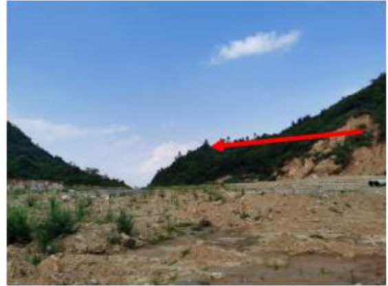
路线止点（接硝洞垭至月坝景区游客中心段公路）
