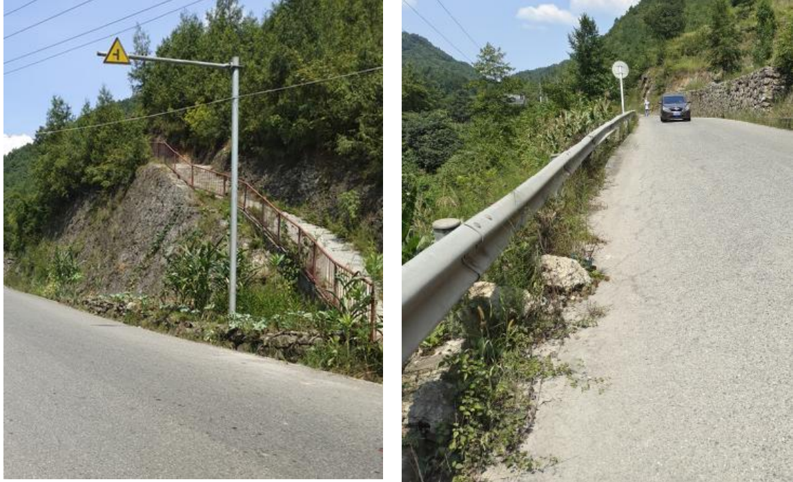
老路交安设施现状
