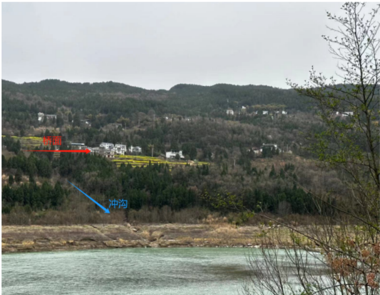
图 3.8-6 笔架大桥现场跨越冲沟图
