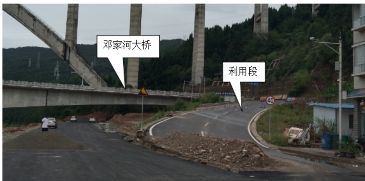
图 3.2-2 邓家河大桥工程引桥段现状
