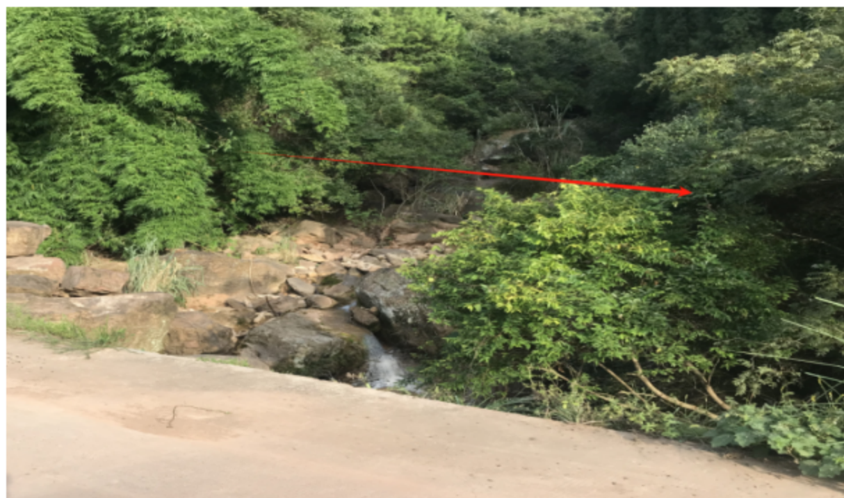
图 3.8-3 龙王沟中桥现场跨越冲沟图
