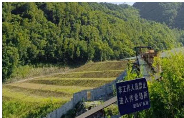
图 4.2-2 李家河尾矿库边坡整理工程
