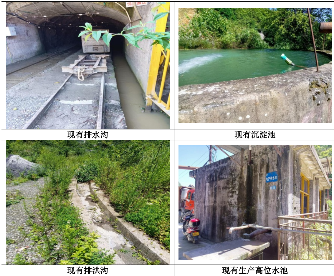
图 3.1-17 矿井涌水现有环保措施
