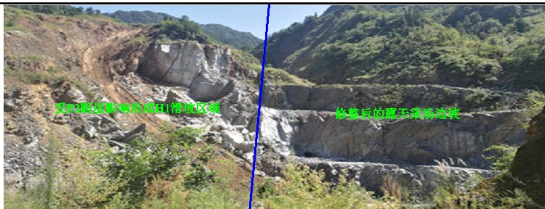
图 3.1-12 露天采场现状照片
