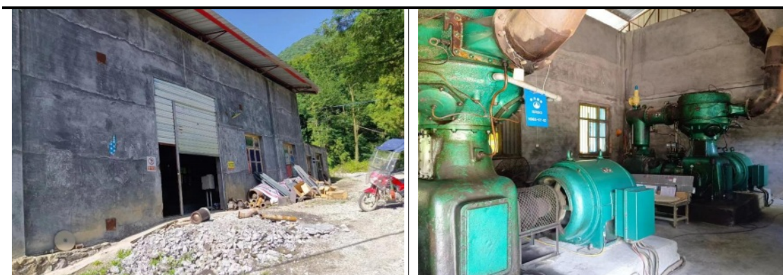
图 3.1-5 空压机房现状图
