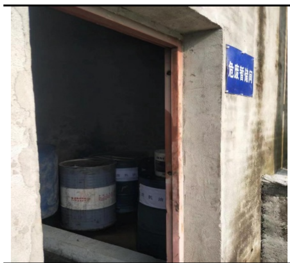
图 3.1-3 危险废物暂存间
