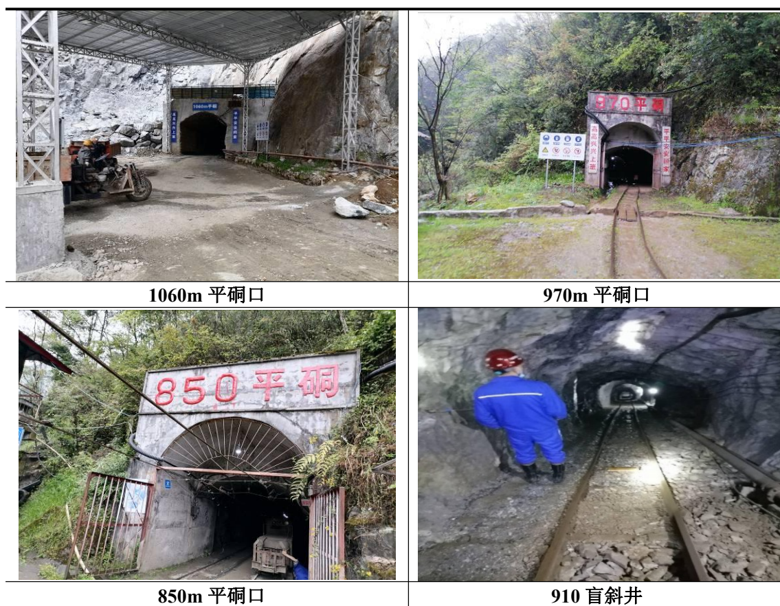
图 3.1-2 地下开采平硐口及巷道
