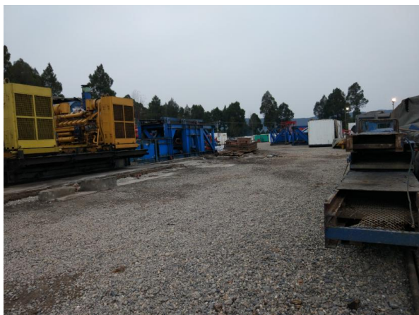
钻井设备和临时活动房未撤离
