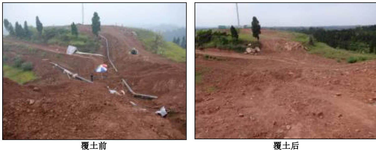
图 9.3-2 区域已有同类工程管沟回填前后对比图
