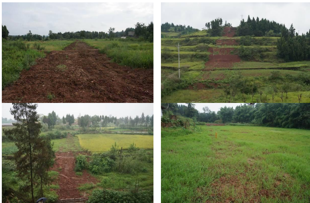
图 9.3-3 区域已有同类工程管道施工恢复情况
