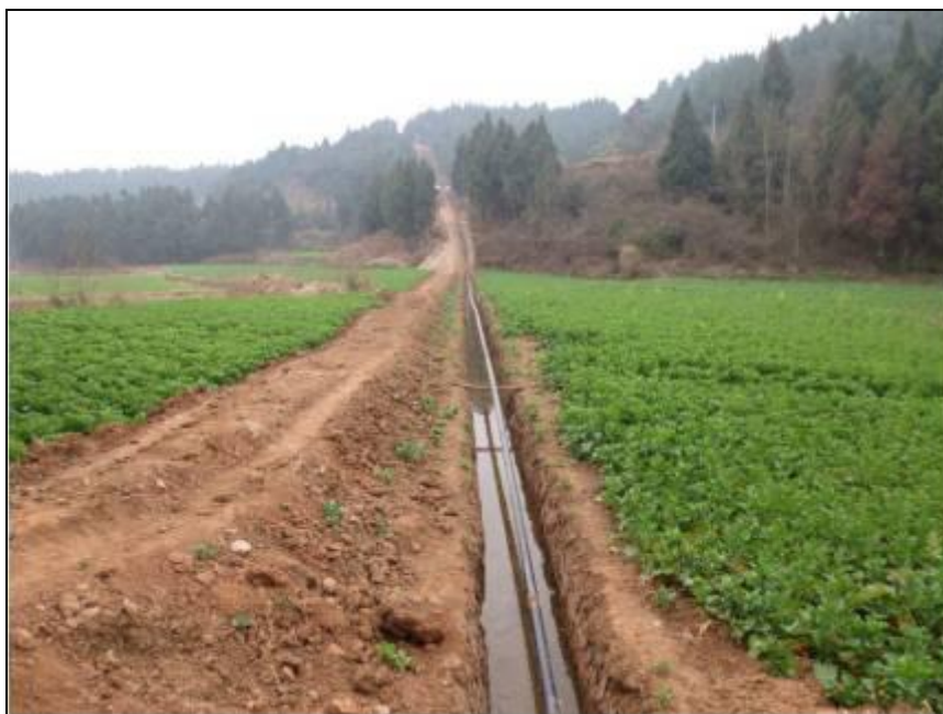
图 9.3-1 同类工程管道穿越耕地时施工作业带图
