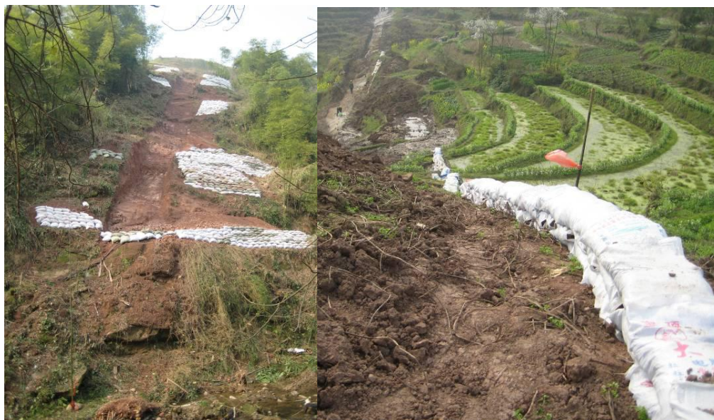
图 3.1-3 施工作业带临时水工保护措施示意图
