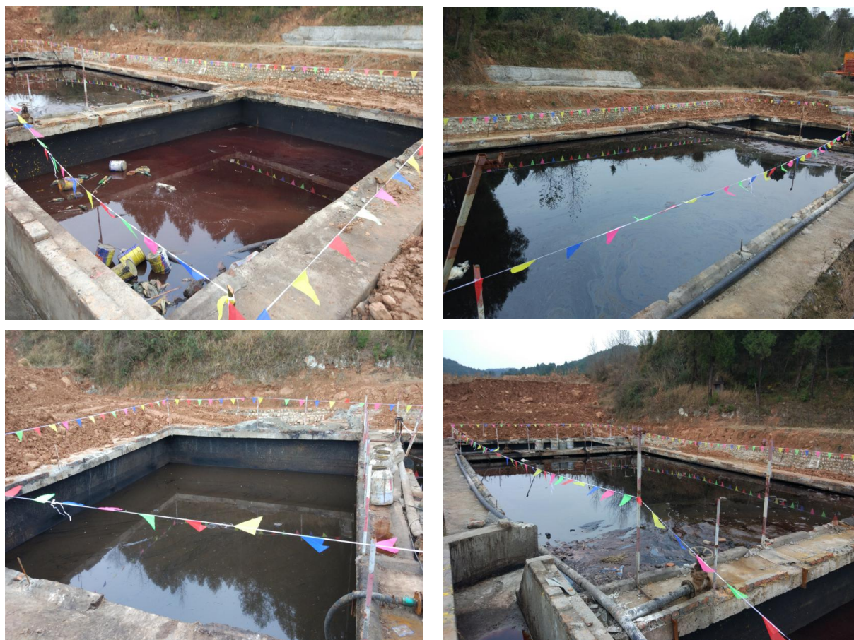
图 2.6-3 钻井岩屑池、废水池现状
