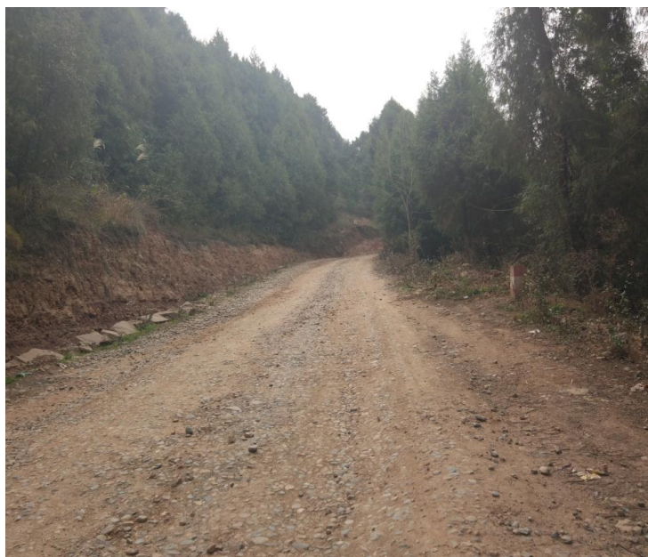
图 2.5-4 管道碎石道道现状
