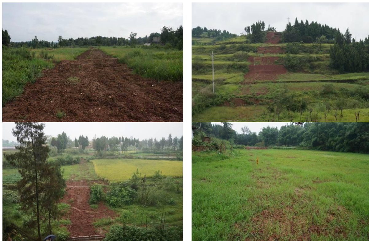
图 7.3-4 区域已有同类工程管道施工恢复情况
