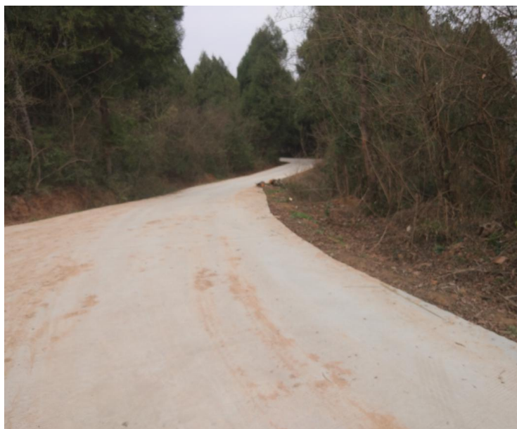
图 2.5-3 管道水泥公路现状
